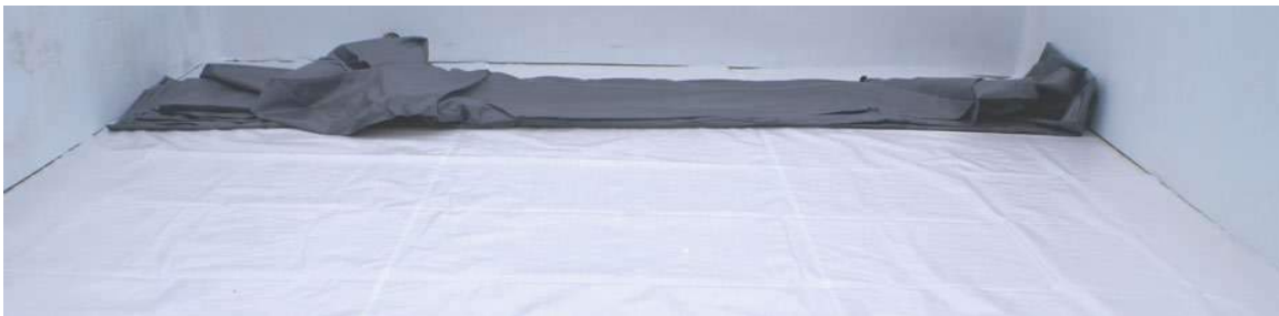
Abbildung 32 – Entfalten der Folienauskleidung
