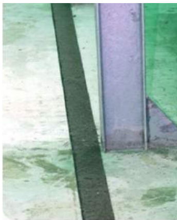
Abbildung 8 – Anbringen der Bitumenstreifen
