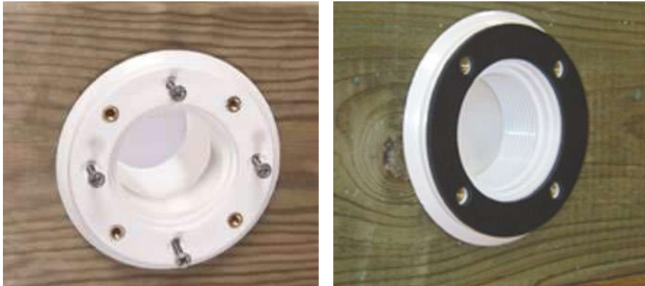
Abbildung 23 – Montage der Ausstoßdüse und seiner Dichtung
