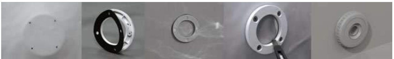
Abbildung 34 – Anbringen des Flansches am Rücklauf
