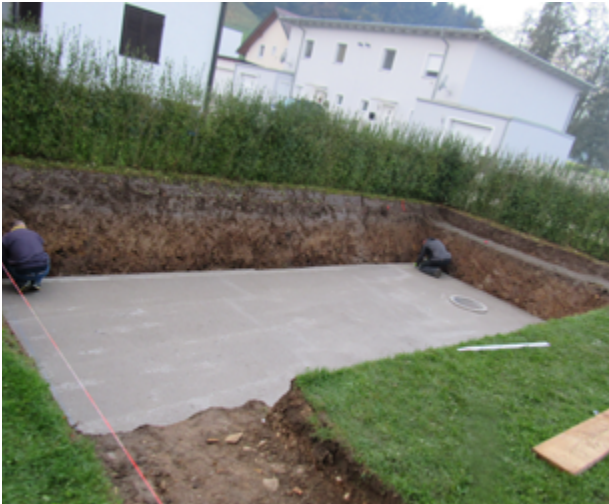
Poolstruktur für Armierungen anzeichnen 1/2
