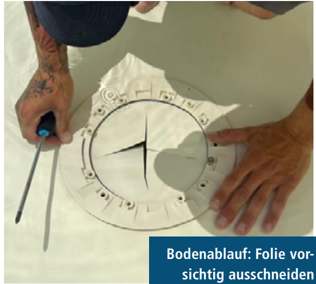
Bodenablauf: Flansch per Hand anschrauben
