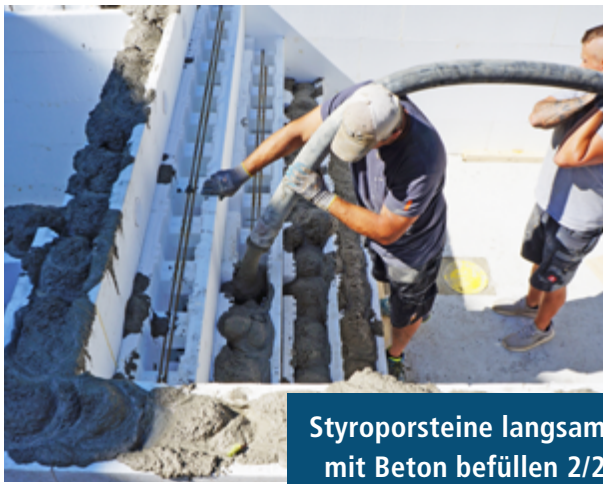
Pool ausspreizen vor Betonfüllung 3/3
