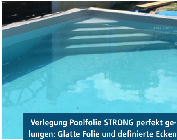
Befüllung beginnen und Beschwerung schrittweise entfernen
