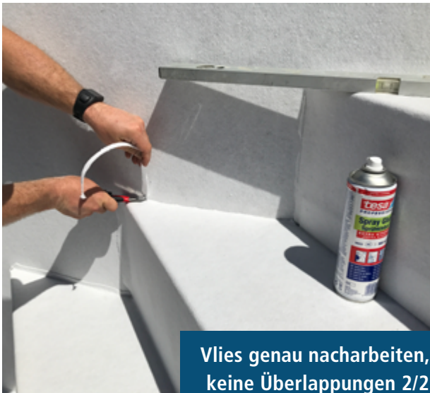
Vlies genau nacharbeiten, keine Überlappungen 1/2
