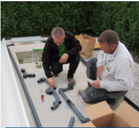
Verrohrung auflegen und sortieren
