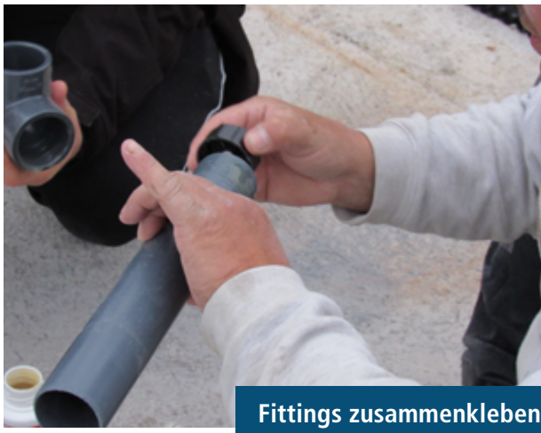
Kleber mit Pinsel auftragen
