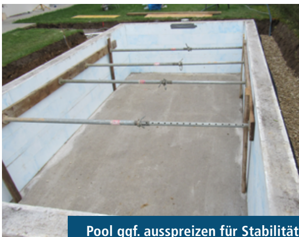
Schotter Hinterfüllung
