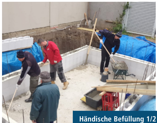
Styroporsteine langsam mit Beton befüllen 1/2
