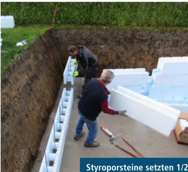
Senkrechte Eisenstäbe einsetzen 1/2
