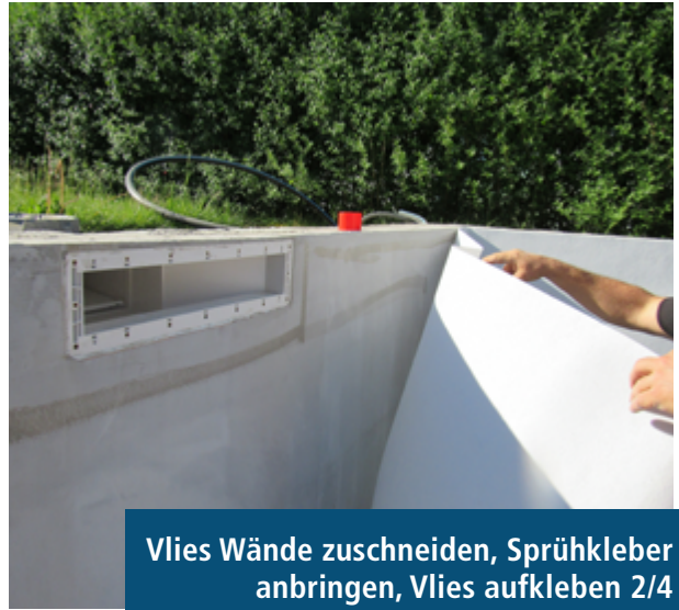
Vlies Wände zuschneiden, Sprühkleber anbringen, Vlies aufkleben 1/4
