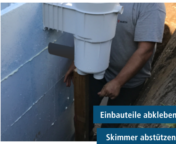
Skimmer ohne Flansch etwas vor die Wand setzen, sodass er später, wenn vernetzt und verspachtelt, bündig abschließt
