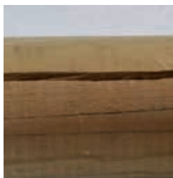
Cracks/Grietas/Fente/Risse/ Crepe/ Barsten/Fendas
