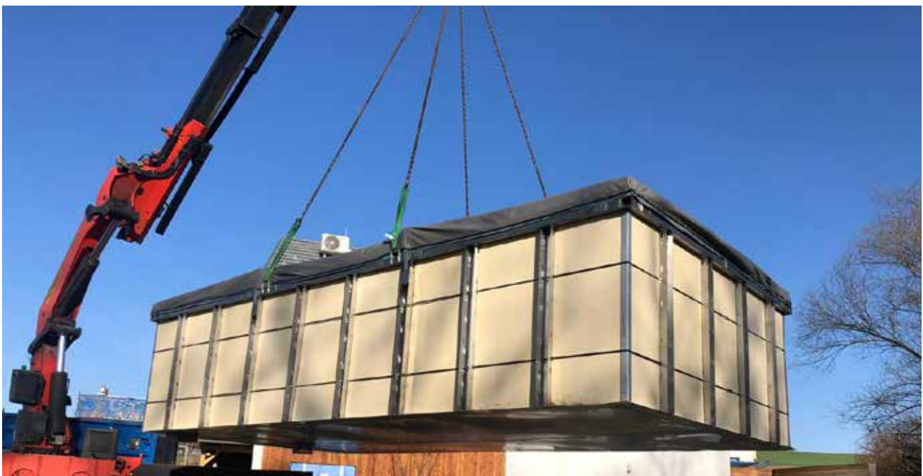
Bild 7: Abladung mit Kran
